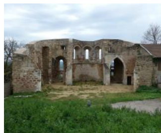
Les vestiges de la chapelle Saint - Cyriaque
