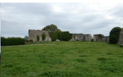
Les ruines des remparts d'enceinte
